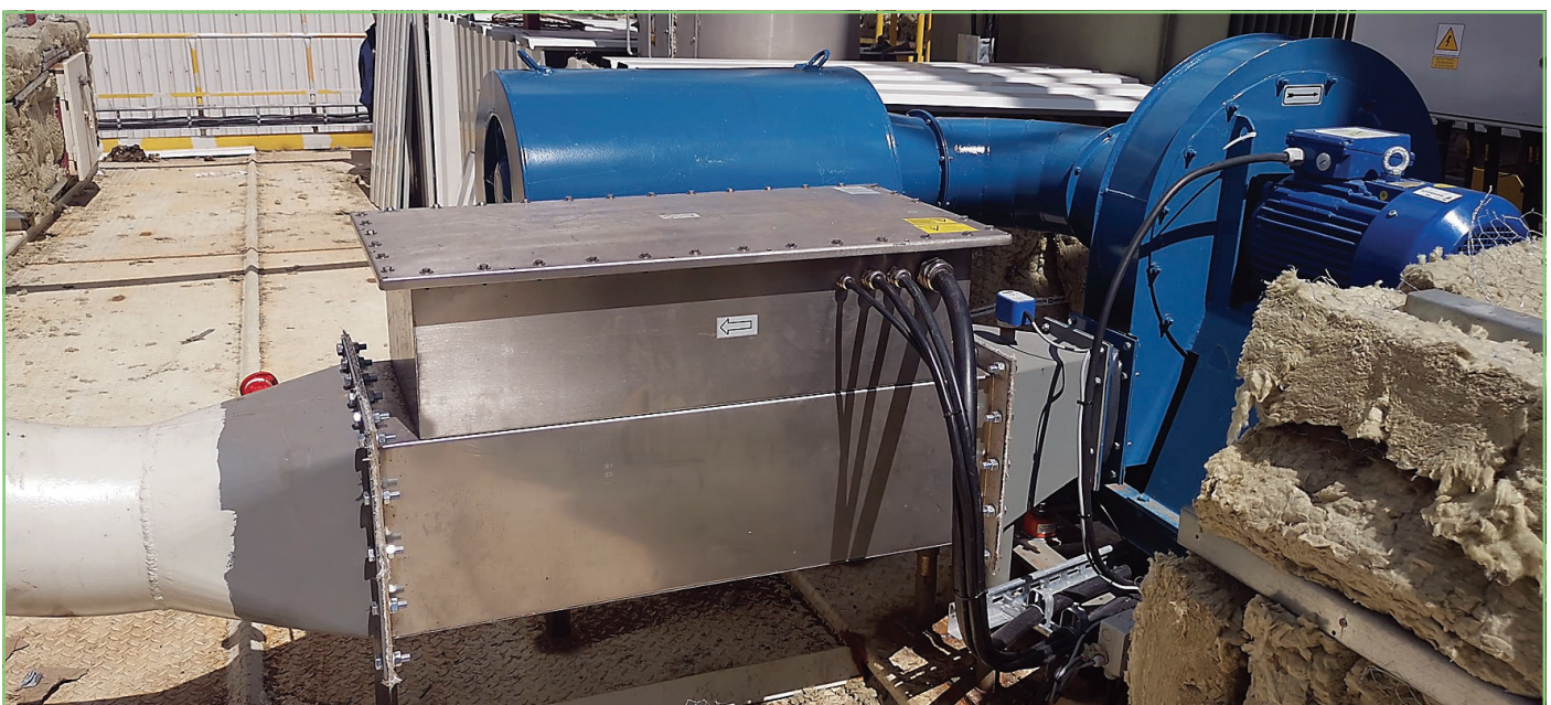
Nagrzewnica EN-40x40-110,0-3-A HT (110 kW, 130°C)
